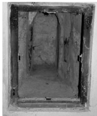
Dahinter wird ein zugemauertes Hagioskop sichtbar, Kirche von Nesse
