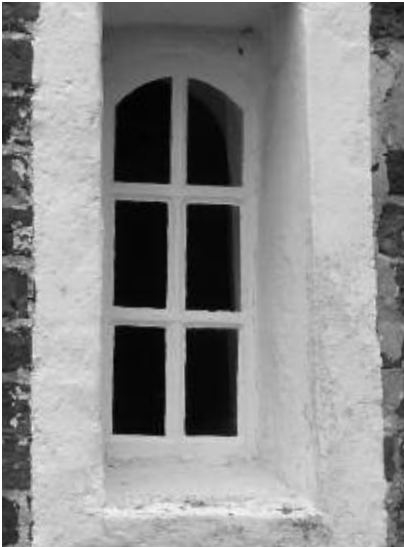
Hagioskop der Kirche von Blersum, Außenansicht, Foto: Ingomar Reiff
